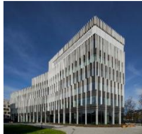
Kotlarska 11 Krakau VF: 11.000 m 2 Fertigstellung: 2017
